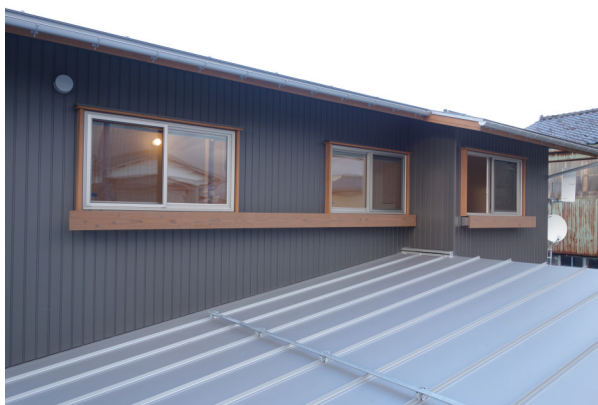
五泉の家 山口工務店様設計施工
